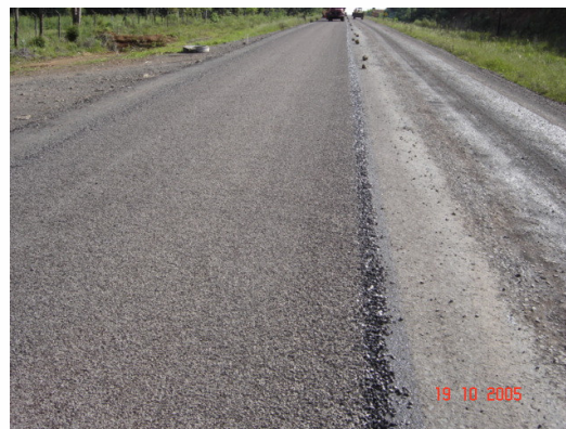
Figura 3.5 – Execução do TSD
