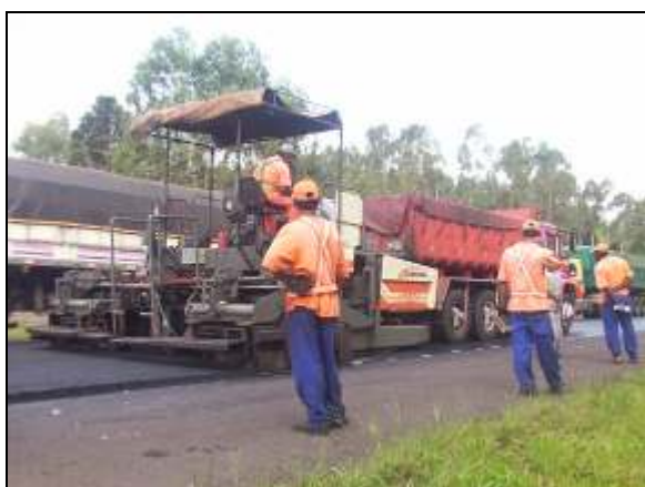
Figura 13 – Espalhamento da camada de concreto betuminoso usinado a quente
