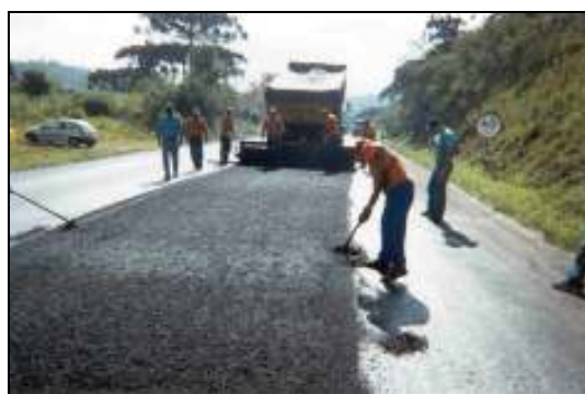
Figura 11 – Segmento logo após a pintura de ligação (esquerda) e reperfilagem (direita)
