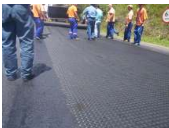
Figura 12 – Instalação da geogrelha de poliéster (esquerda) e da grelha de fibra de vidro (direita)
