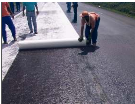
Figura 12 – Instalação da geogrelha de poliéster (esquerda) e da grelha de fibra de vidro (direita)
