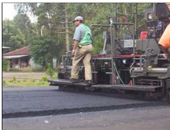
Figura 13 – Espalhamento da camada de concreto betuminoso usinado a quente
