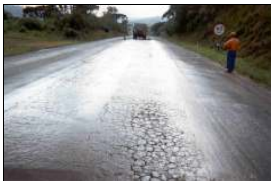
Figura 11 – Segmento logo após a pintura de ligação (esquerda) e reperfilagem (direita)
